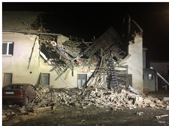
Obr. 8. Poškozený dům a okolí po výbuchu v Tursku.
